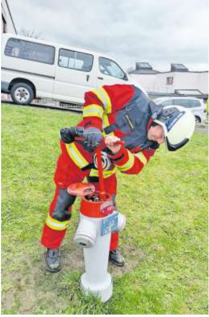
Im Bild links öffnet der Feuerwehrmann mit einem Hydrantenschlüssel den Hydranten. Das Bild in der Mitte zeigt ein Tanklöschfahrzeug für den Leitungsbau. Und dann sollten Feuerwehrleute auch wissen, wie die Leitern funktionieren. Auf dem Bild rechts ist eine Gruppe zu sehen, welche soeben die Steckleiter zusammenbaut. (Bilder zvg)
