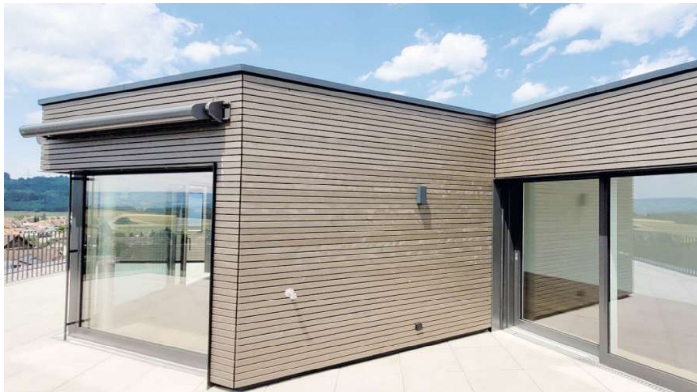
Grosse Holzfassade in Hedingen. 11.5 km Rhomboidschalung und 83 Fensterfutter wurden bei der Lärchenfassade verbaut.
