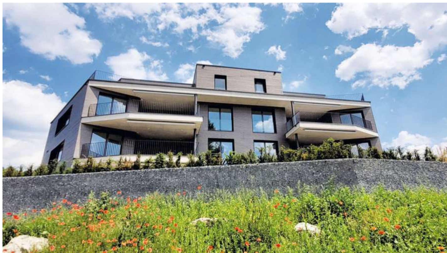
Grosse Holzfassade in Hedingen. 11.5 km Rhomboidschalung und 83 Fensterfutter wurden bei der Lärchenfassade verbaut.
