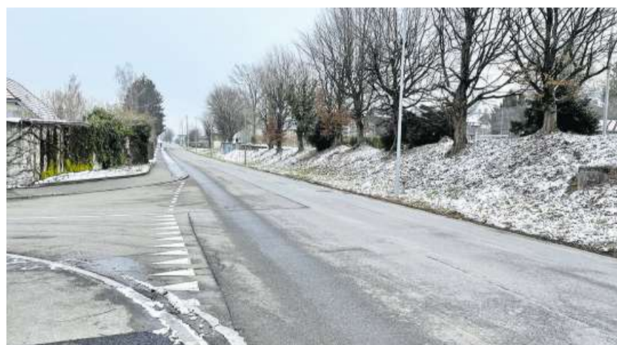
Die Ottenbacherstrasse in Obfelden wird bis November saniert. (Bild Dominik Stierli)
